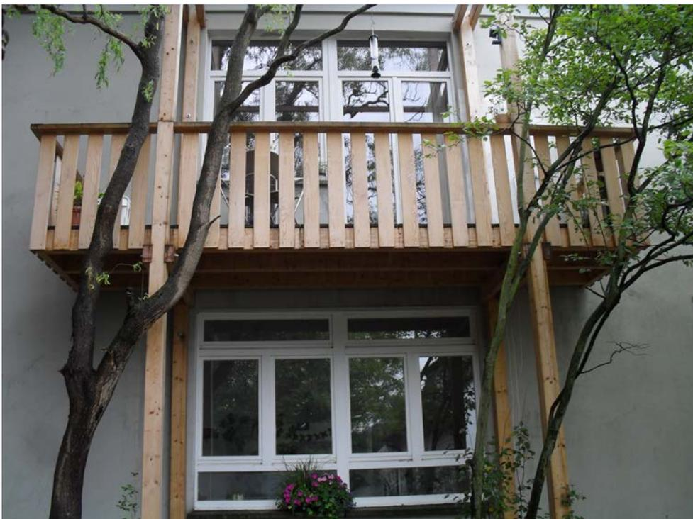
Balkon aus Lärche Massivholz, eingearbeitet in einen Baumbestand
